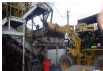
廃棄物混合状況
