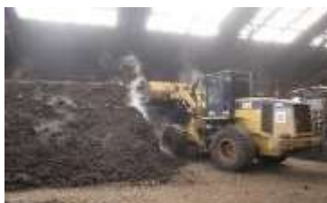
重機を使用した作業状況
