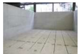
高圧通気システム
