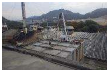
汚泥貯留ホッパー
