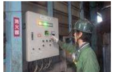
巡回監視状況
