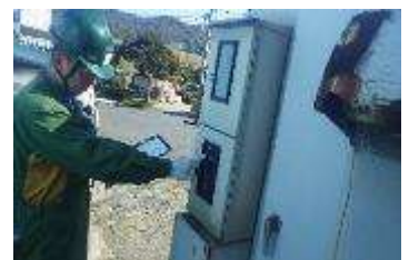
電力データ収集状況
