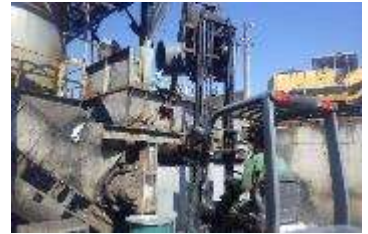
廃棄物混合状況
