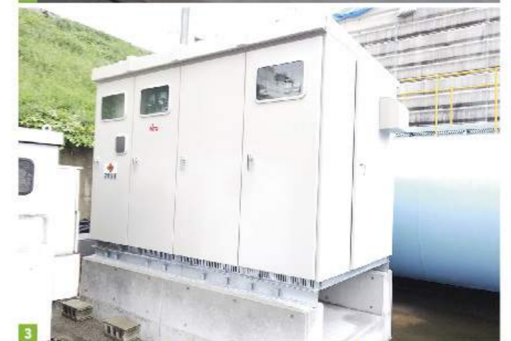
1 飛散防止用防護ネット 2 土間コンクリート整地状況 3 新設キュービクル
