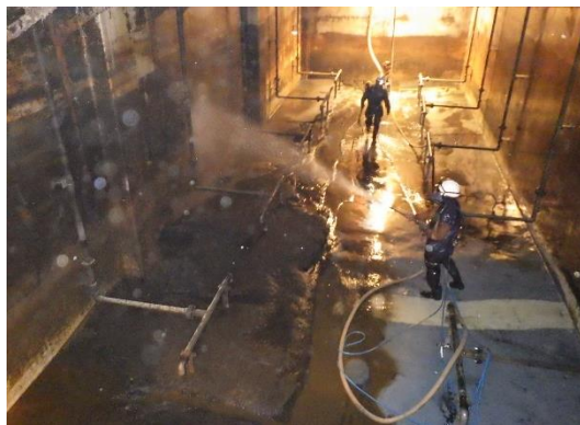
排水処理施設洗浄作業の様子
