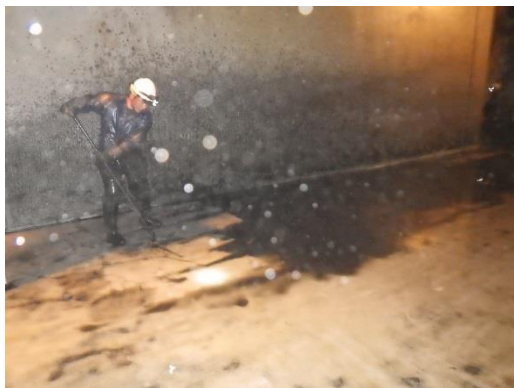
排水処理施設清掃作業の様子
