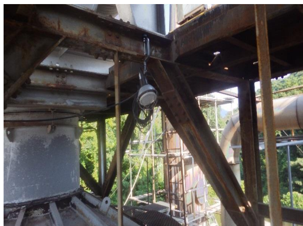
施設照明のLED化
