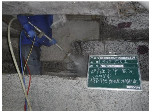
防食工事超高压洗浄の様子
