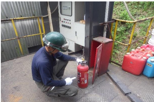
消火器点検の様子
