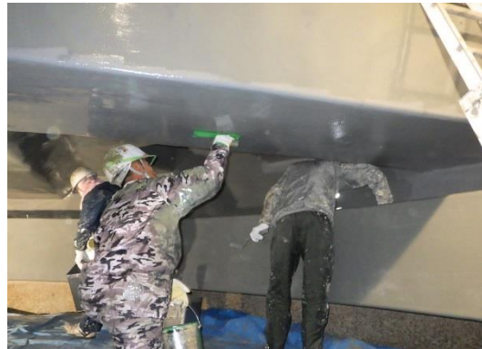
防食作業の様子
