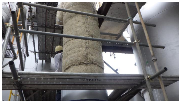
設置作業の様子
