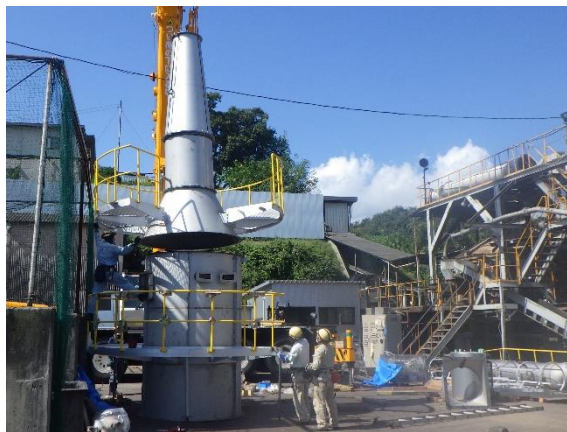
焼却炉改修工事の様子
