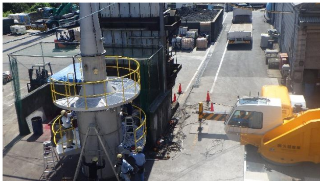
設置作業の様子
