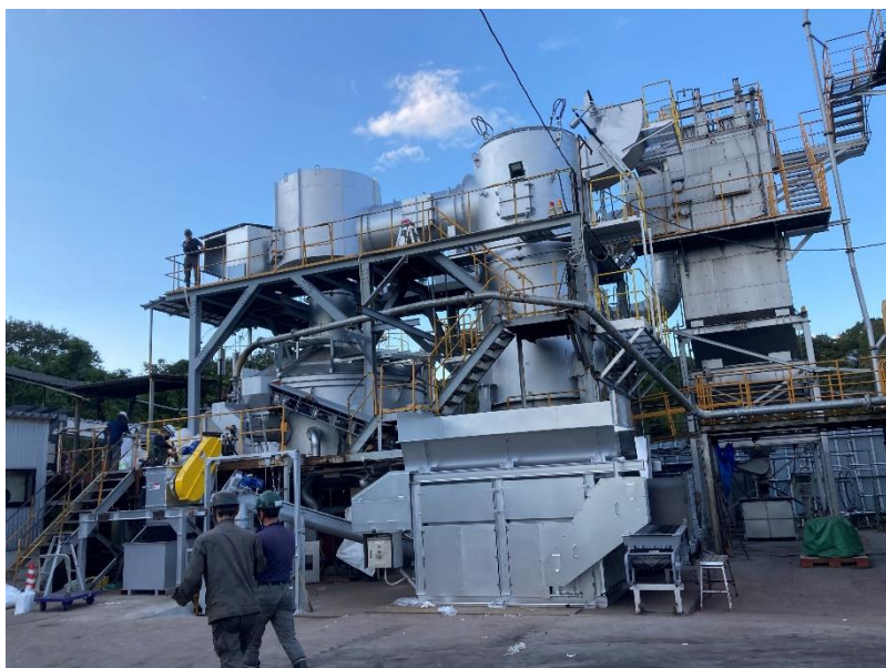
改修工事完了後の回転炉床式焼却炉
