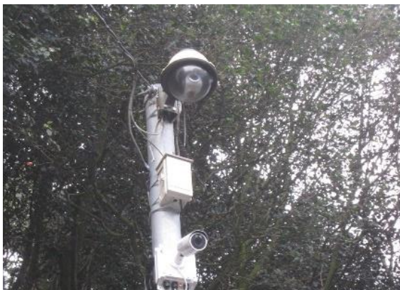
防犯カメラ設置の様子
