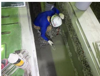
耐酸モルタル塗布の様子
