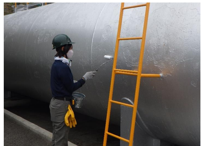
塗装作業の様子
