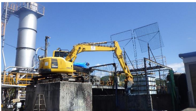
本社工場破碎作業の様子
