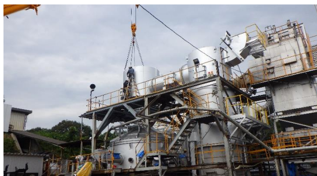
設置作業の様子
