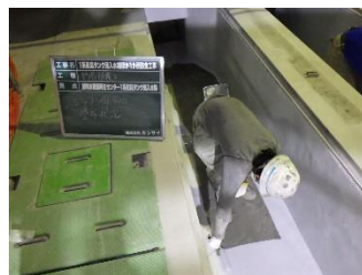
防食作業の様子
