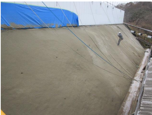
吹付工事の様子
