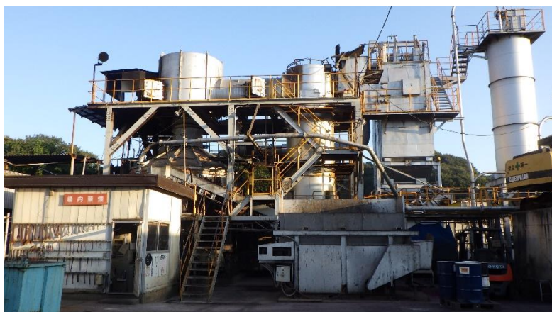
改修工事前の回転炉床式焼却炉
