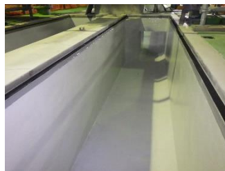
工事完了の状況
