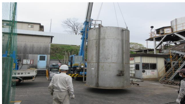
解体作業の様子
