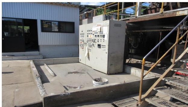
解体作業の様子
