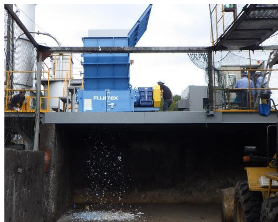
破碎機試運転の様子
