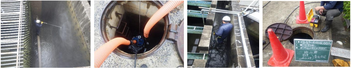
浚渫工事の様子
