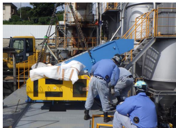
破碎機工事の様子
