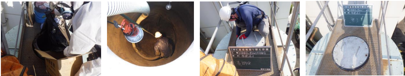
脱臭装置整備工事の様子
