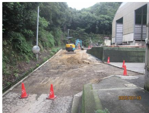
修繕工事の様子
